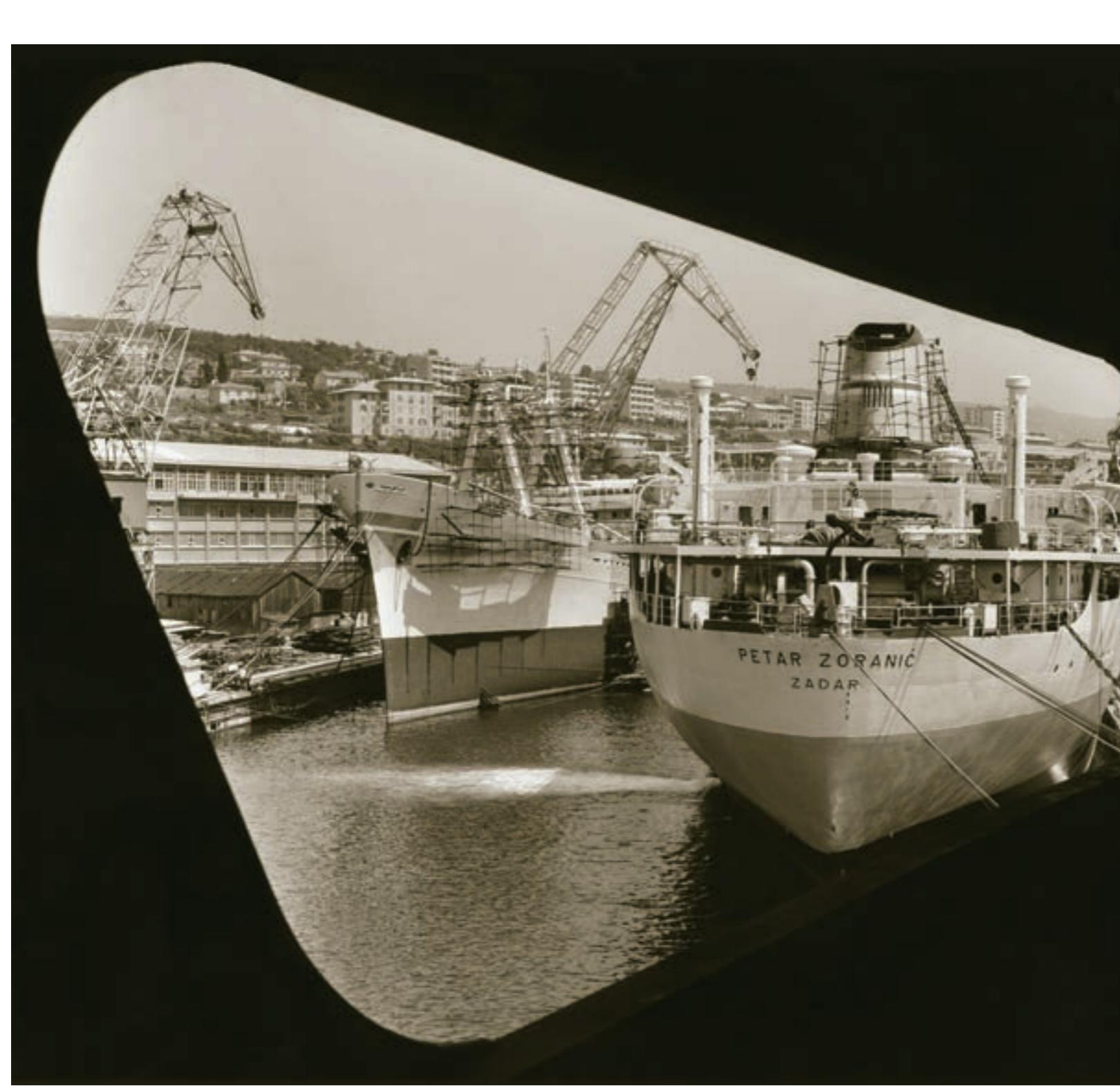
*Uporedno s rekonstrukcijom i modernizacijom pojedinih dijelova brodogradilišta usvaja se nova tehnologija i proizvodnja novih modela i sve većih brodova. Petar Zoranić, tanker od 25.330 DWT, isporučen 1960. godine do tada je najveći izgrađeni brod u našoj zemlji.*
