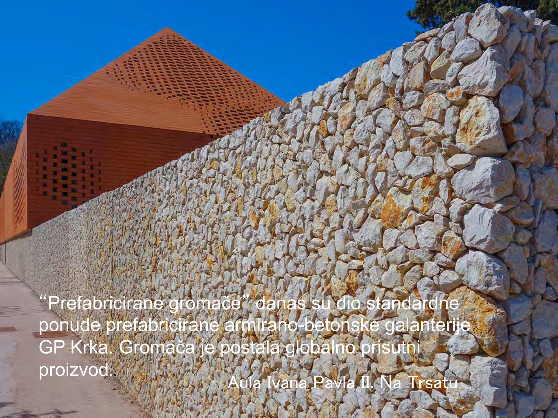
“Prefabricirane gromače” danas su dio standardne ponude prefabricirane armirano-betonske galerijerije GP Krka. Gromača je postala globalno prisutni proizvod..
